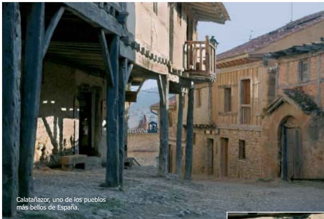
Fachada entramada con madera de sabina y paños «encastados» enlucidos con barro y mortero de cal.
