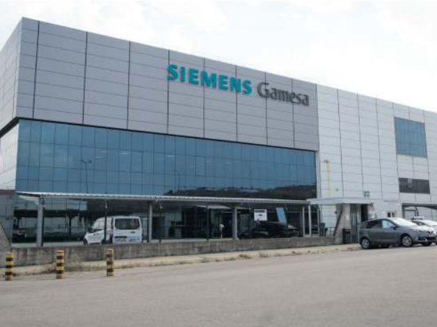
Fachada de la empresa Siemens Gamesa.
