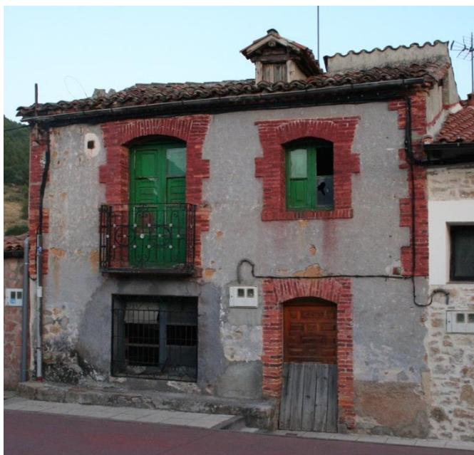
Ilustración 161. Edificación con la incorporación de materiales con origen en la industria, insertados en una edificación tradicional. Muriel Viejo. Foto: JLSG.
