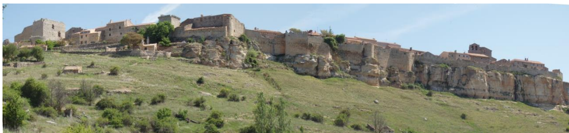
Ilustración 237. Fotografía: Rello. Junta de CyL, Portal de Patrimonio Cultural
