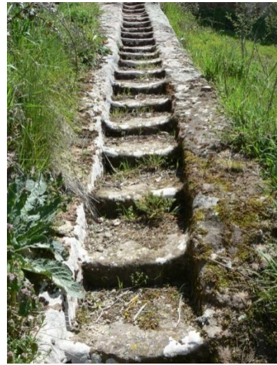
Ilustración 304. Fotografía: Paso escalonado de 35 escalones tallado en la roca. En Inventario de los Bienes Inmuebles del Patrimonio Etnográfico , por Ángel Coronado, 2007, http://157.88.193.21/~bipe/index.php
