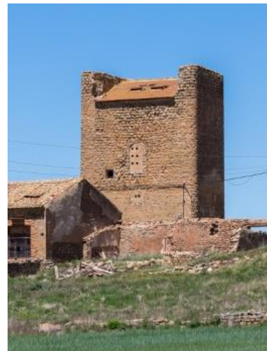
Ilustración 247. Fotografía: Torre de Villanueva de Zamajón. Junta de CyL, Portal de Patrimonio Cultural
