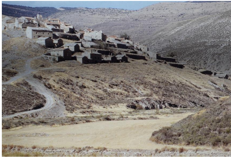
Ilustración 378. Fotografía: Conjunto de arquitectura tradicional en Castillejo de San Pedro. Por F. Benito Martín. En la arquitectura tradicional de Castilla y León . Página 275, 1998,
