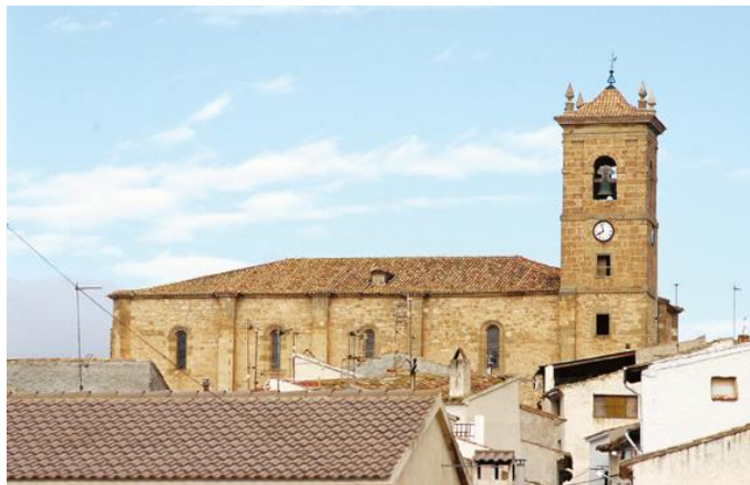
Ilustración 215. Fotografía: Iglesia en Deza. Junta de CyL, Portal de Patrimonio Cultural
