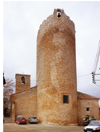
Ilustración 219. Fotografía: Iglesia en Hinojosa. Junta de CyL, Portal de Patrimonio Cultural
