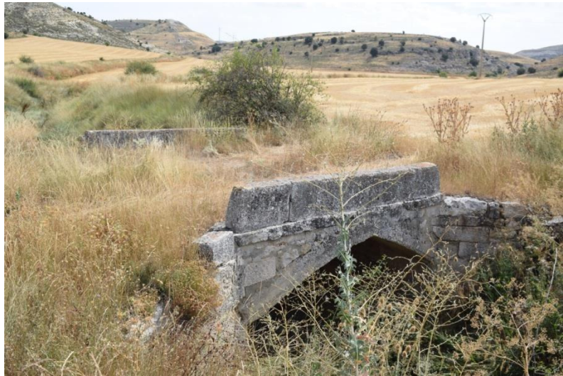
Ilustración 294. Fotografía: Puente sobre el río Torete. Por M. Duque Fernández, 2018.
