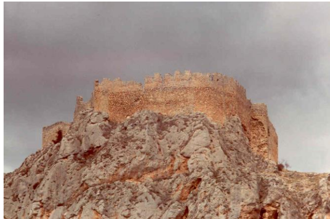
Ilustración 212. Fotografía: Castillo de Ciria. Junta de CyL, Portal de Patrimonio Cultural
