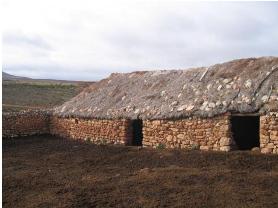
Ilustración 346. Fotografía: Taina de Valdegalindo. Por Sanz Aragonés, A., Benito Batanero, J.P., Tabernero Galán, C. En Construcciones con tierra vegetal en el sur de la provincia de Soria . 2006, CD anexo.
