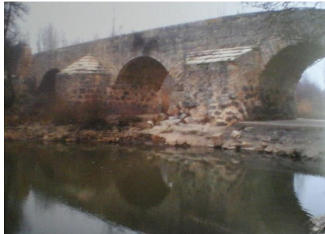
Ilustración 275. Fotografía: Puente en Gormaz. Por Arancón Viguera, A. (2011) Puentes históricos y singulares sobre el Duero en la provincia de Soria . Soria: Diputación Provincial. P. 144.
