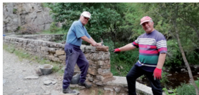
Arreglos de restauración del puente. Foto: J. Luis García.
