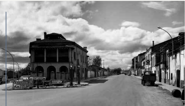
La rectilínea Avda. Salazar y Torres. A la izquierda surtidores de gasolina, y detrás la casa de Nieves Martínez Cortázar, de 1944
