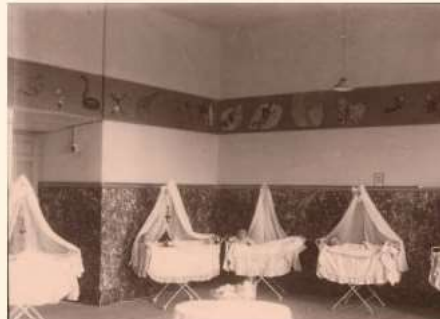
Casa cuna AHPSO 460.
