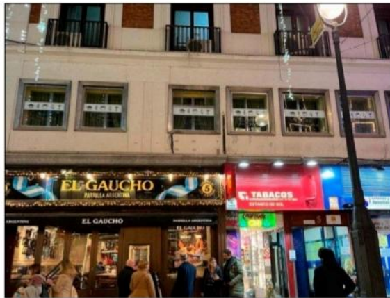
Inmueble de la Casa de Soria en Madrid que pertenece a la Diputación. HUDS
