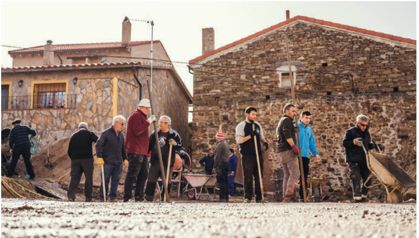
El trabajo dignifica. Varios socios de Sarnago colaboran en la construcción de nuestro próximo proyecto, vivienda con espacio coworking. Foto Marcos Carrascosa
