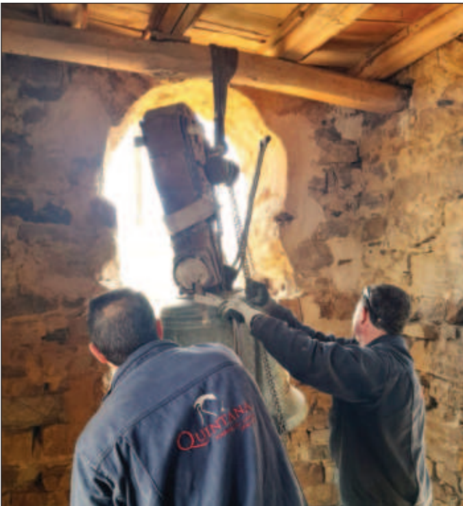
Desmontando la campana
