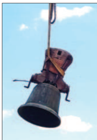
Extracción de la campana
