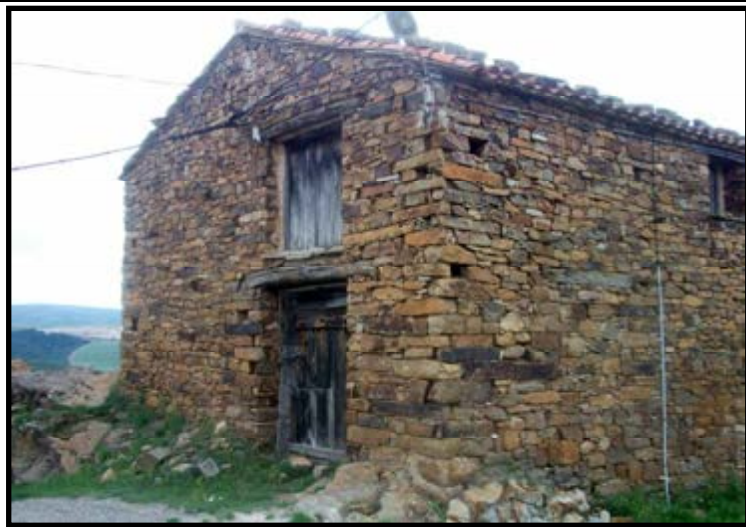
“La Casilla” de Sarnago, detalle de la colocación de las piedras de las paredes. Foto José Mari Carrascosa
