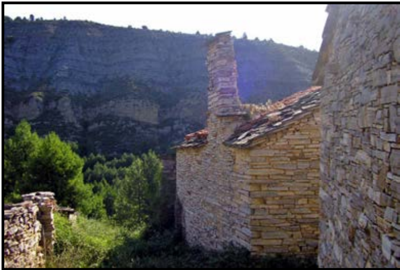
Paredes de casas construidas en El Vallejo con “losas” planas. Foto José Mari Carrascosa
