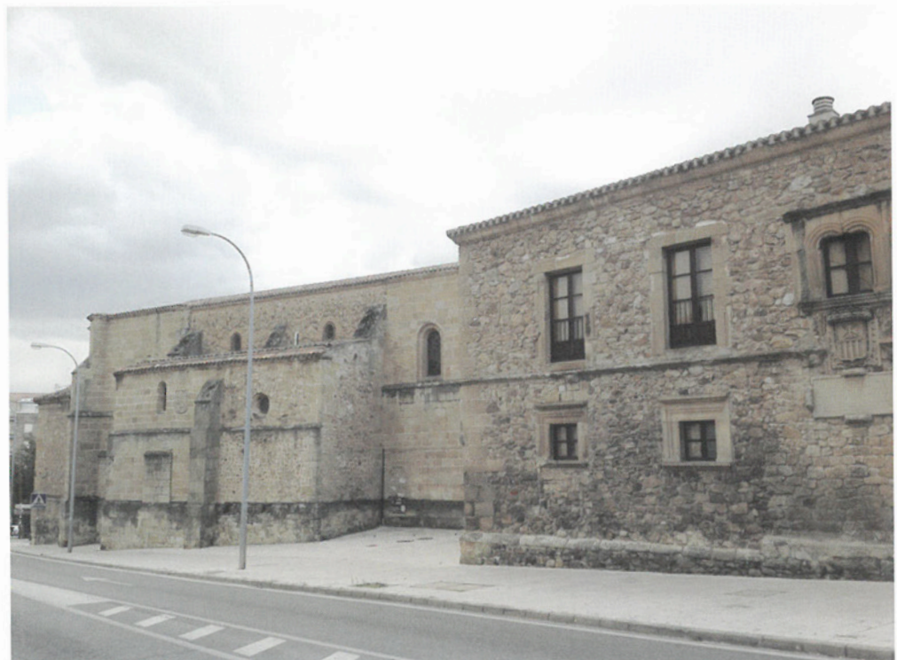
Fachada norte del Monasterio de la Merced
