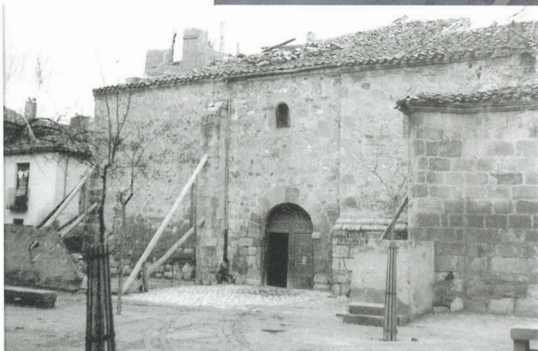
Fachada de la Iglesia de San Clemente
