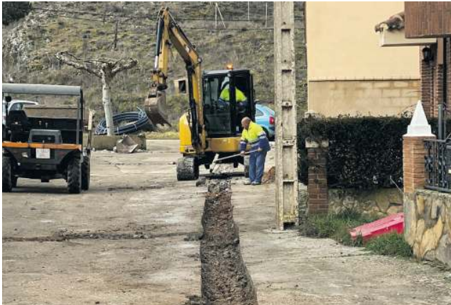
Una actuación que se llevó a cabo en la mejora del ciclo del agua.
