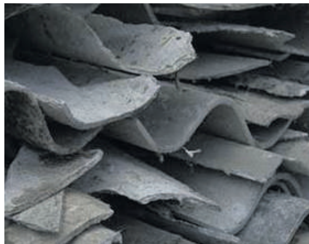
Placa ondulada compuesta por fibrocemento con amianto.
