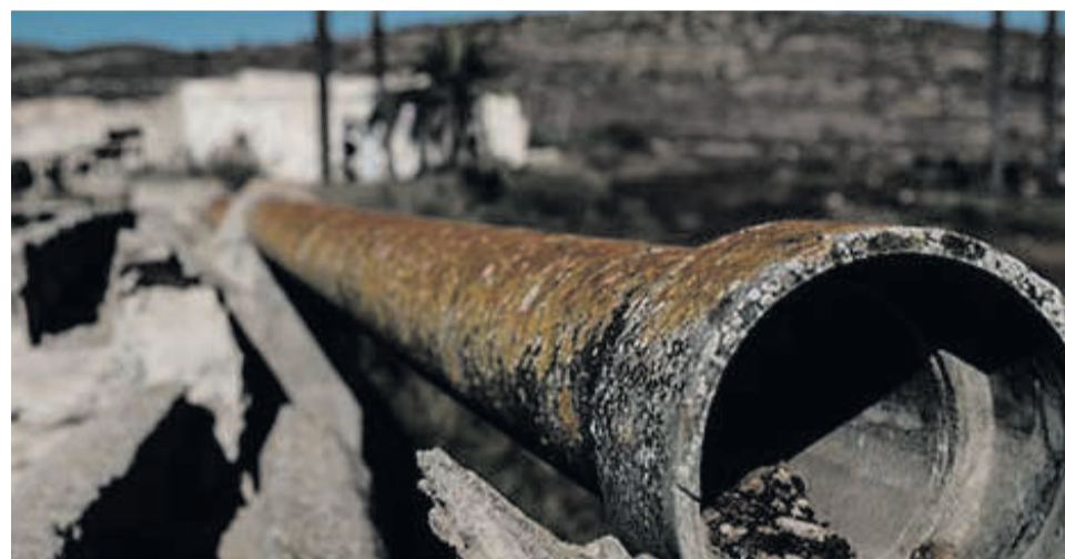
Tubería con fibrocemento.
