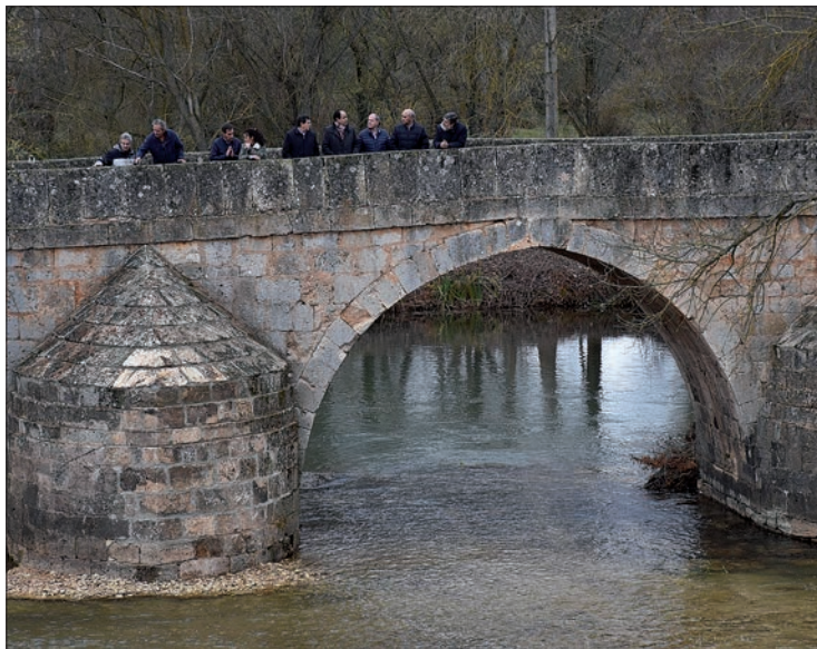
El tajamar del puente, totalmente rehabilitado. / JUNTA CASTILLA Y LEÓN
