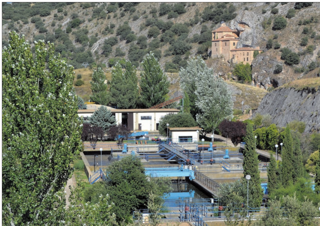
Depuradora actual de la ciudad de Soria. /S.N
