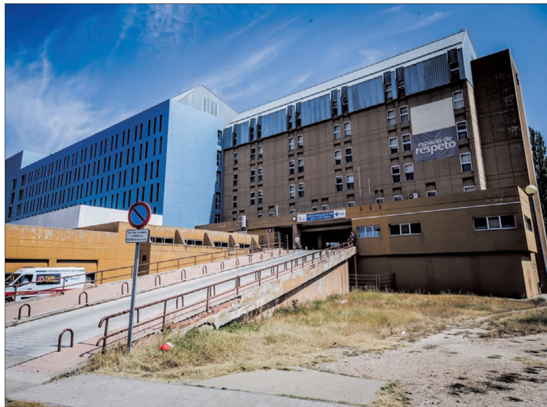
Vista exterior del Hospital Santa Bárbara de Soria. /SN
