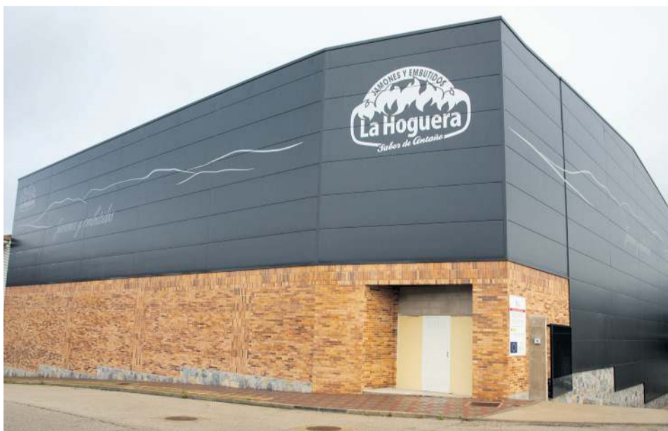
Exterior del edificio de ampliación de las instalaciones: 3.000 metros cuadrados más en tres plantas.
