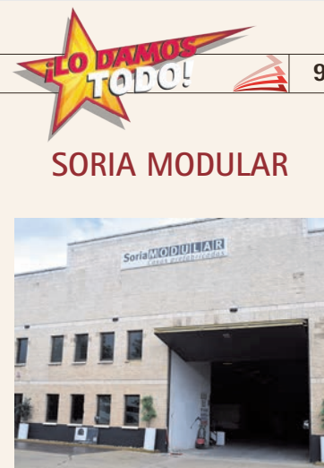
Instalaciones de Soria Modular.
