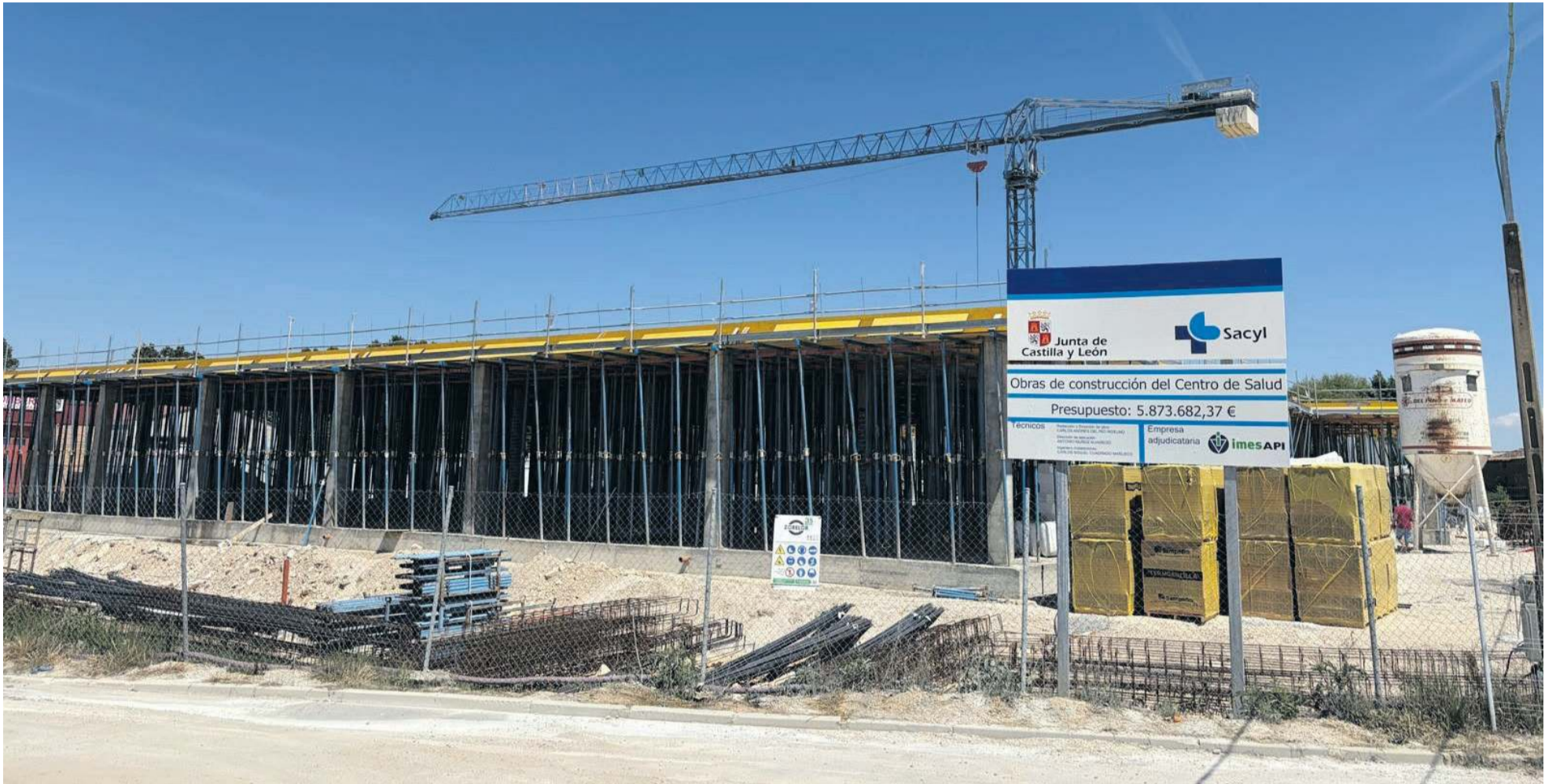
Seguimiento de las obras del Centro de Salud de El Burgo de Osma.
