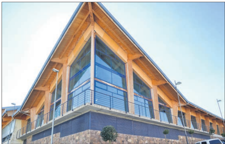
Exterior de las piscinas cubiertas de Ólvega. /CH.A.
