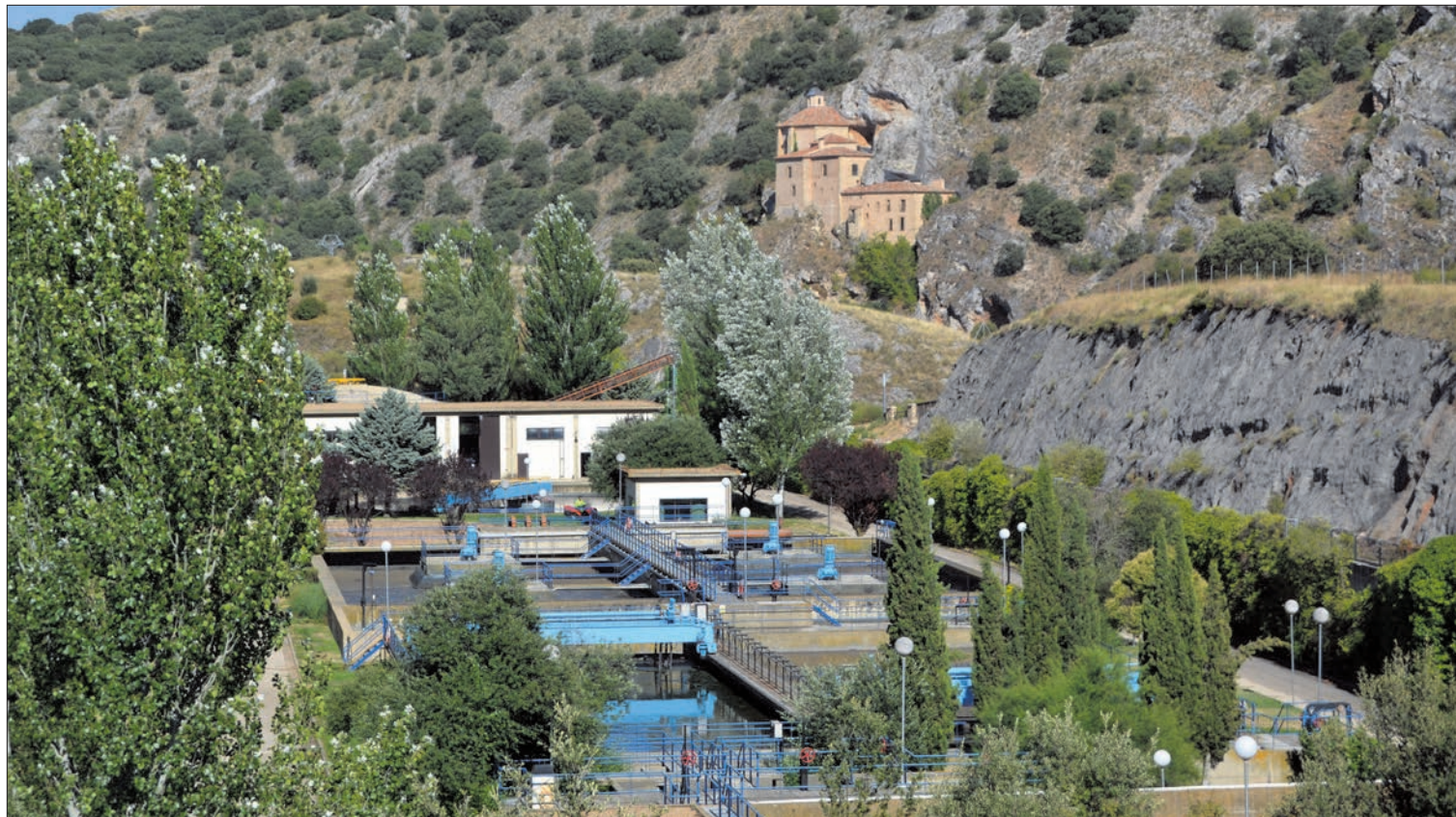
Actual depuradora de Soria que será sustituida por la nueva EDAR de Los Rábanos.
