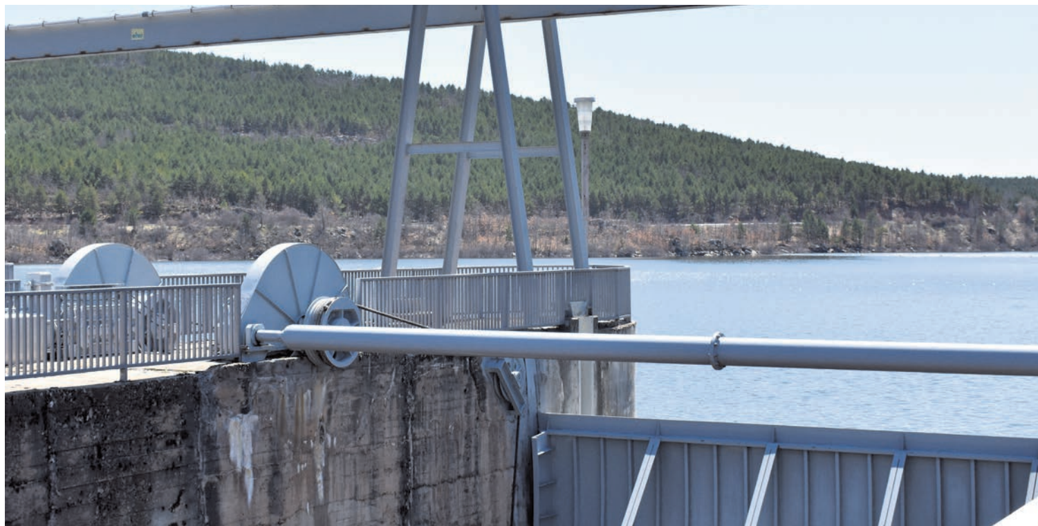
Imagen actual de la presa del pantano de la Cuerda del Pozo.
