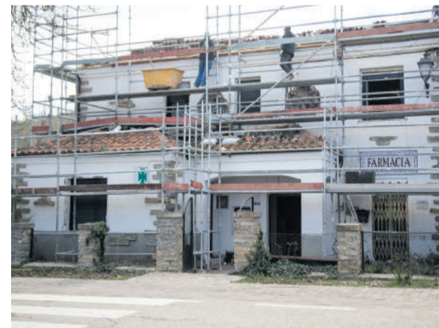
Obras en el inmueble de la farmacia.
