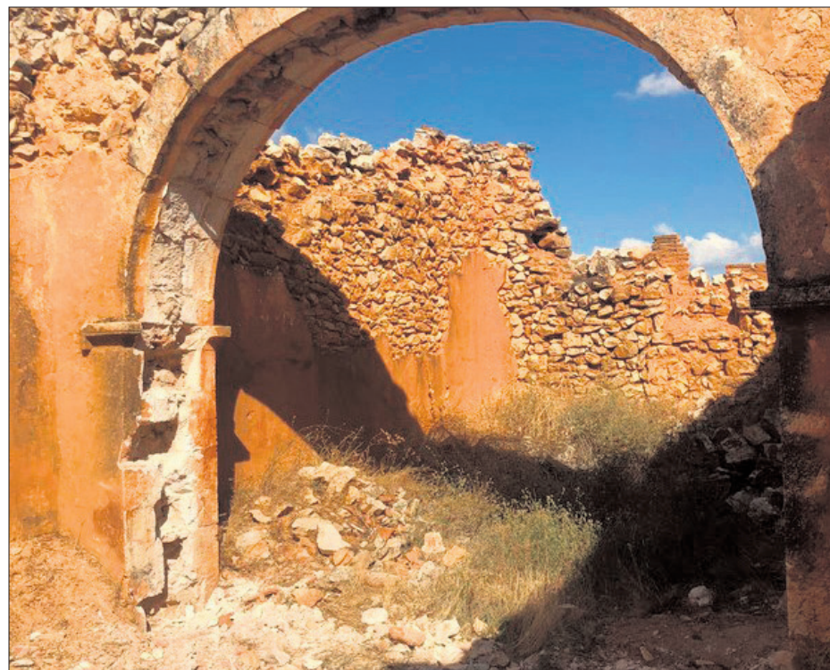
A la izquierda, imagen que tenía la portada de la ermita de San Lorenzo de Boós. A la derecha, aspecto de la portada después del expolio, tras arrancar las columnas románicas y los sillares del arco.
