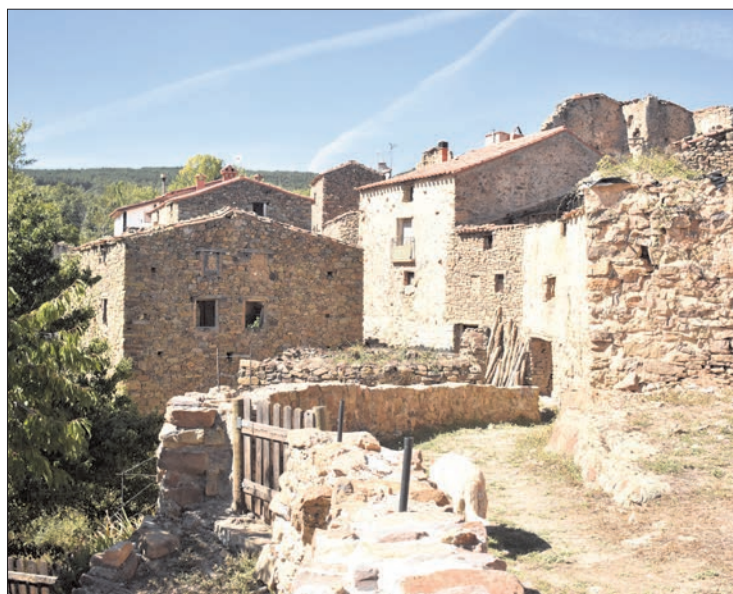
En La Vega conviven casas rehabilitadas con solares en ruina.
