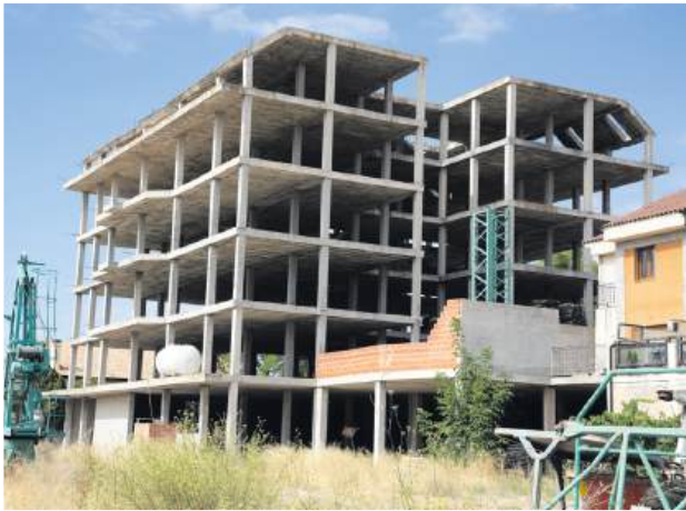
Inmueble privado inacabado.
