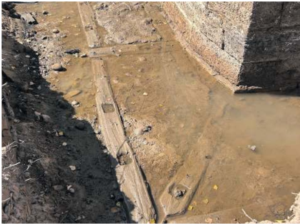
Estructura de madera que protegía los pilares.
