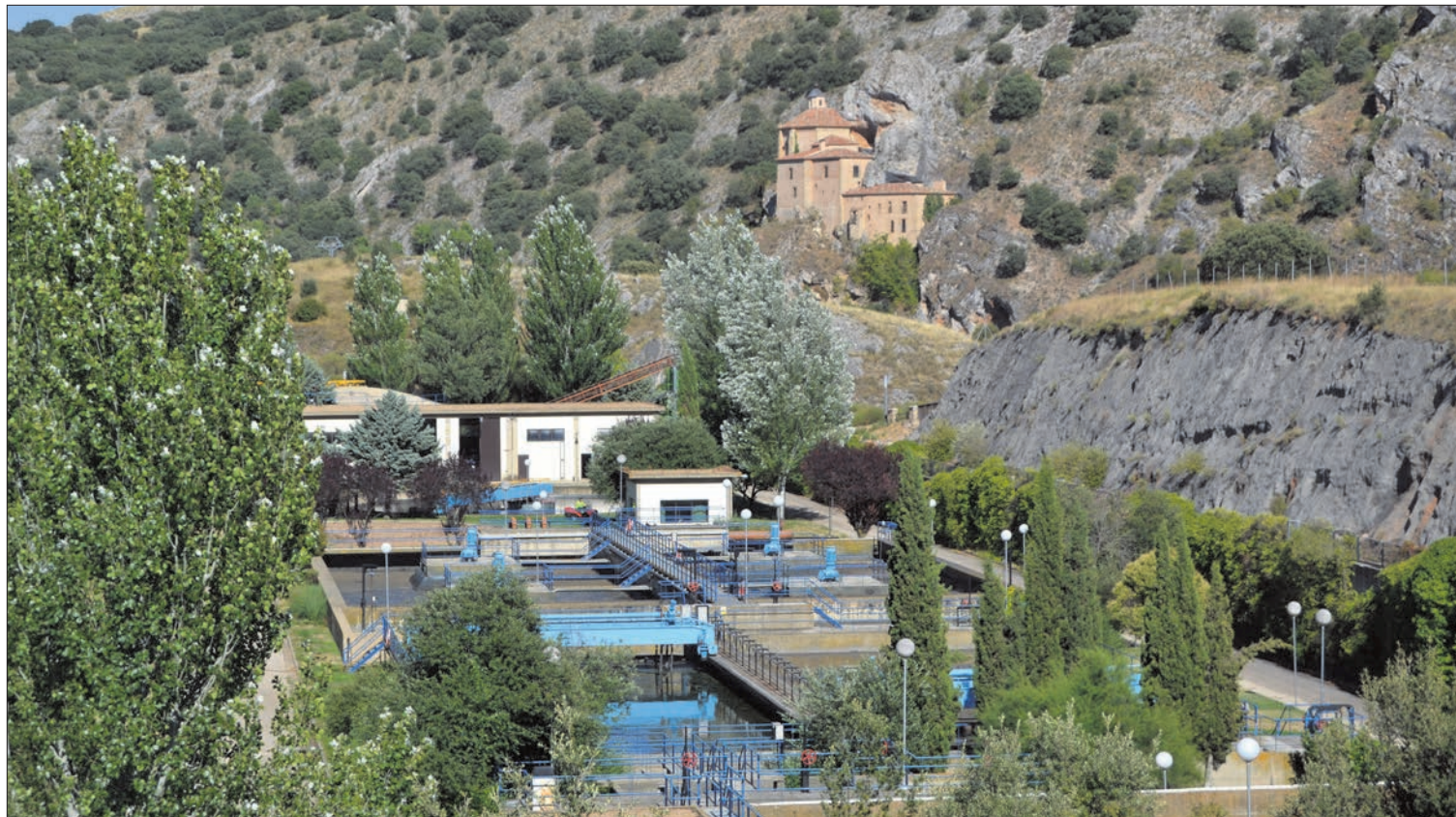
Imagen de la actual depuradora de Soria.
