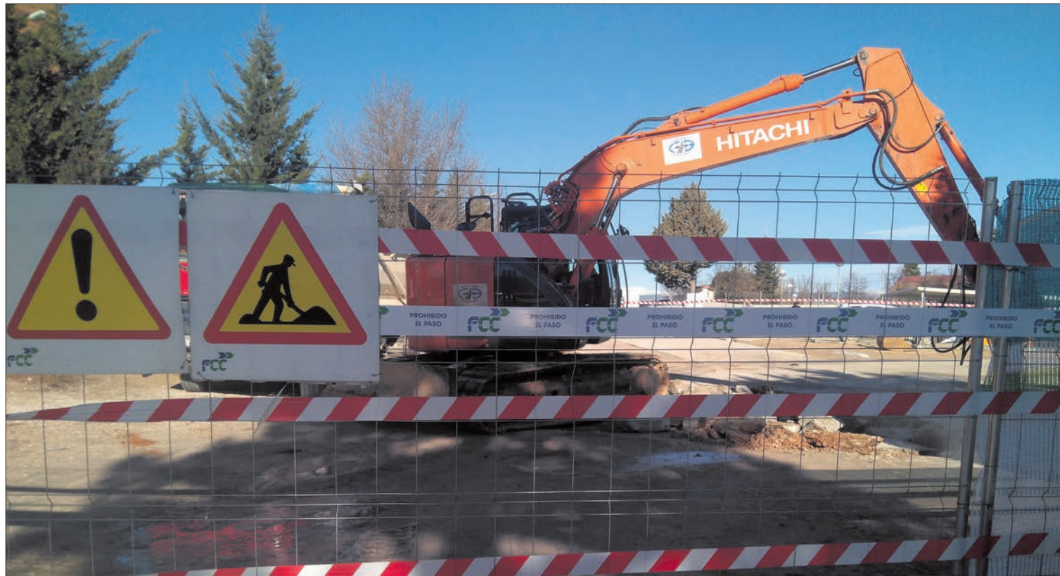
Máquinas y señalización de obras forman ya parte de la imagen del hospital soriano. /SN
