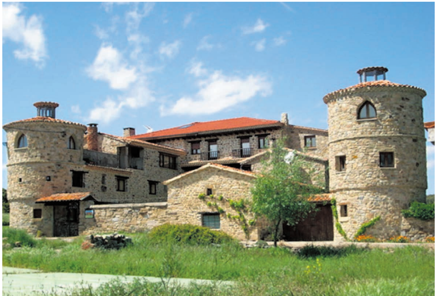
El edificio en piedra y sus dos torreones son seña de identidad del Hotel Santa Coloma./S.N.
